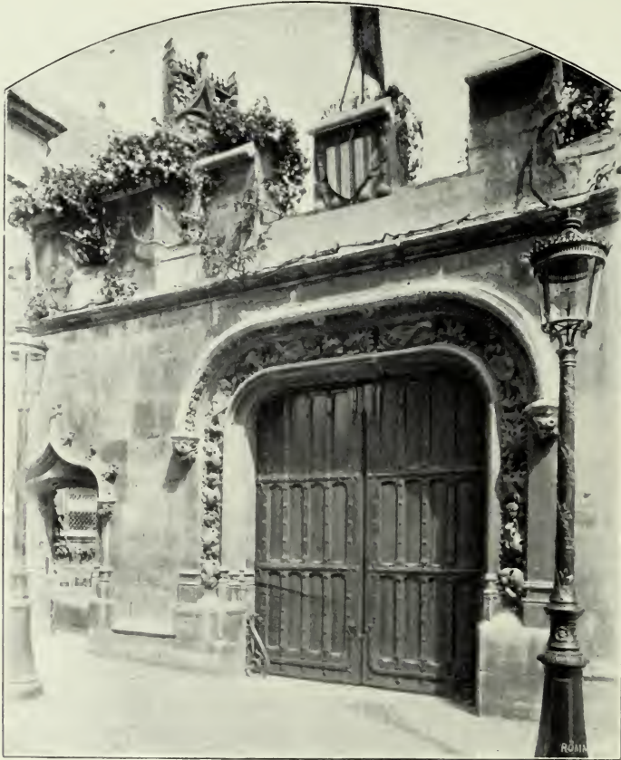
Abb. 43. Portal des Hotel de Cluny in der Rue de Sommerard.
